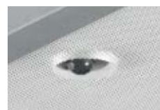
Tageslicht- und Anwesenheitssensor Daylight- and movement sensor
